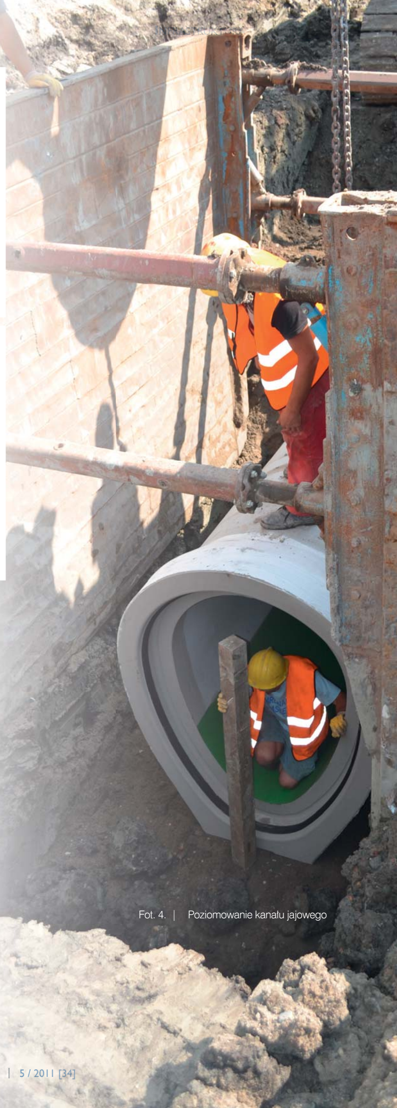
Fot. 3. | Moment opuszczania rury 1000/1500 do szalunku
