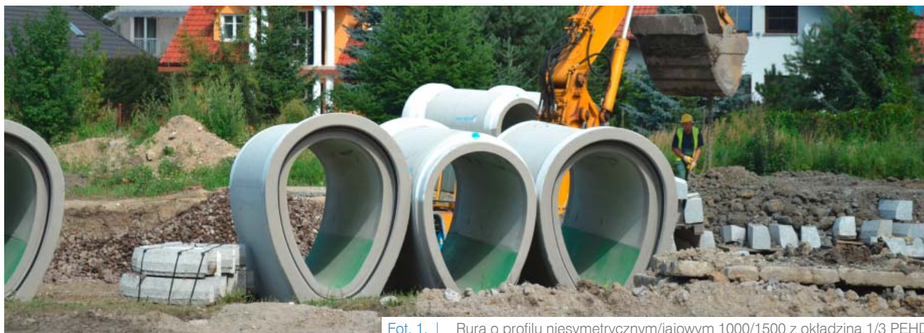
Fot. 1. | Rura o profilu niesymetrycznym/jajowym 1000/1500 z okładziną 1/3 PEHD
