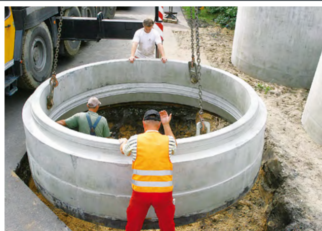
Pose simplifiée grâce aux ancrages de levage
